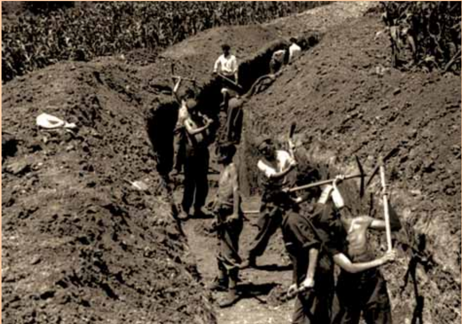
Efectivos republicanos excavan una trinchera en algún lugar del oriente de Asturias para hacer frente a la ofensiva general ordenada por Franco sobre Asturias en septiembre del 37.
